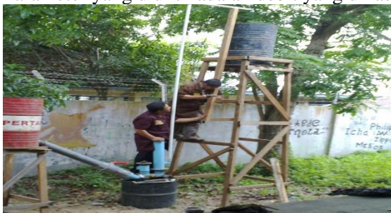
Gambar 4. Pemasangan instalasi Pengujian
